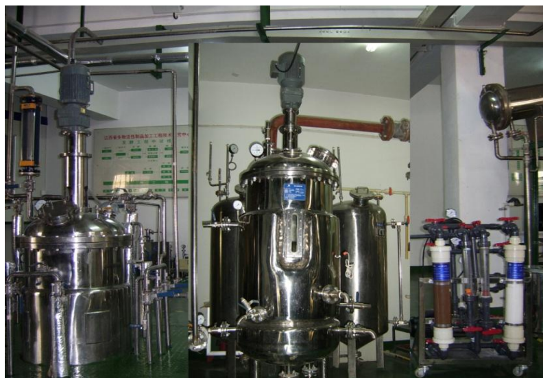
400L 发酵罐-300L 多功能提取罐-80L 超/微滤膜组合装
